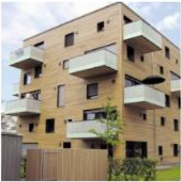
KRUISLAAGHOUT Kruislaaghout (oftewel Cross Laminated Timber, CLT) is een houtbouwproduct. Het zijn...
