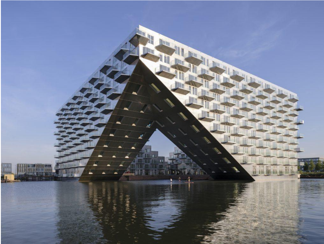
Aan de IJ-zijde is de onderkant van het havenblok weggesneden. Beeld Ossip van Duivenbode
